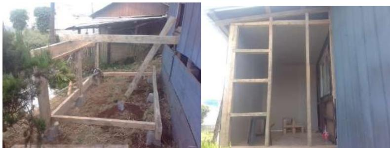
Preparación de envigado de piso para ejecución del baño proyectado - Proceso de ejecución de tabiquerías de baño proyectado.
