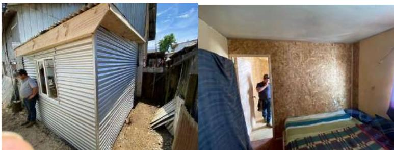
Ampliación de dormitorio terminada. Trabajo de revestimientos interior terminado, además se cambió, revestimiento de muro existente, que se encontraba en malas condiciones
