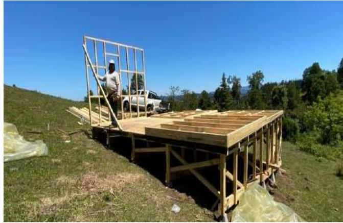
Trabajos en etapa de fundaciones y envigado de piso - Envigado de piso terminado, con piso instalado, comienzo proceso de construcción de tabiquerías.
