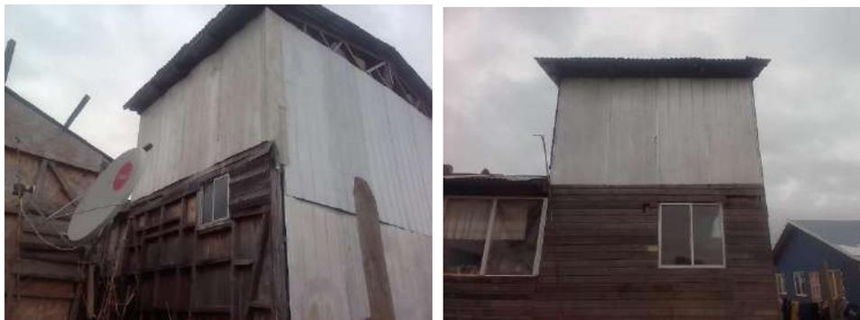
Fachada lateral derecha existente, se aprecia mala instalación de revestimientos, y la falta de éste en primer y segundo piso.
