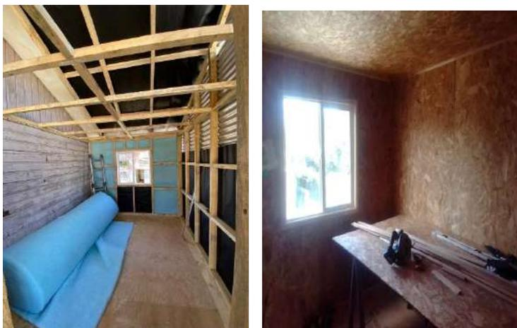
Instalación de aislación térmica e hídrica en los dos recintos - Revestimiento interior terminado.
