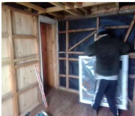
Trabajos previos en dormitorios 2º nivel (propietario ayudando)- Proceso instalación material aislante y revestimientos interiores
