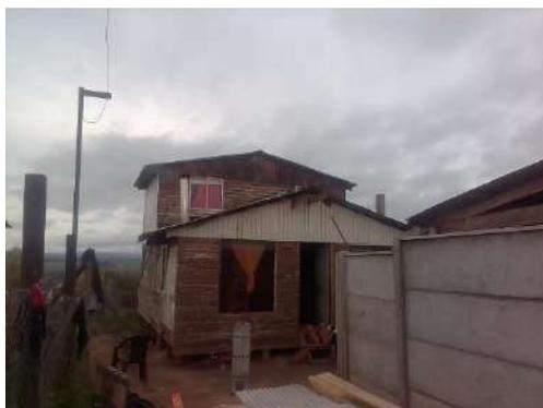
Fachada principal, mal estado de revestimiento exterior de dormitorios, (segundo piso), además de ventanas en mal estado.
